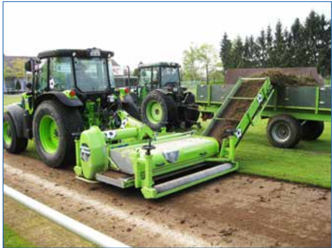
2016 Sanierung des Hauptspielfeldes: Abfräsen der alten Grasnarbe
